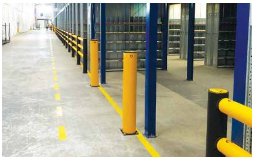
Schutz von Maschinen, Gebäudeteilen sowie von besonders schützenswerten Installationen.
